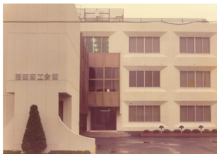
【9月：沼田商工会館取り壊し】
