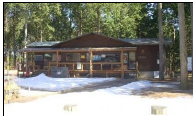
休憩室を併設した管理棟
