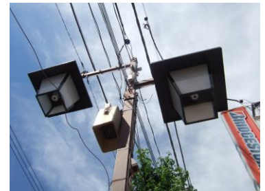
【工事後のLED街路灯】
